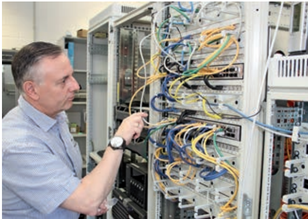
Roberto Jung, federführender Mitarbeiter der dreiköpfigen IT-Abteilung, schaltet im klimatisierten Serverraum, in der Raddasstraße 18, Datenleitungen.
