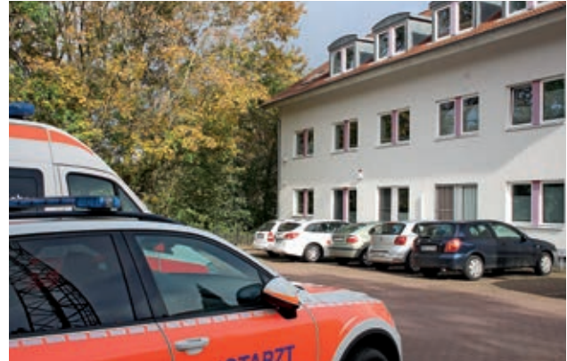
Blick auf die alte Geschäftsstelle des Kreisverbandes, welche ab 2019 zu einem weiteren Gebäudekomplex für den Rettungsdienst umgebaut wurde. Zusätzlich sind in der obersten Etage Ingo Schmidt, Bauleiter im Verein, und das Gebäudemanagement unter Leitung von Sarah Lockenvitz untergebracht.
